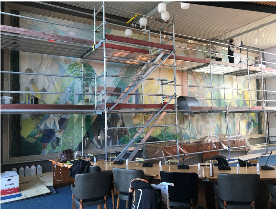
Maleriet "En kommune skabes" af Carlo Rosberg i byrådsalen, Hvidovre Rådhus. Et stillads i 2 etager måtte benyttes for at komme til hele maleriet.
