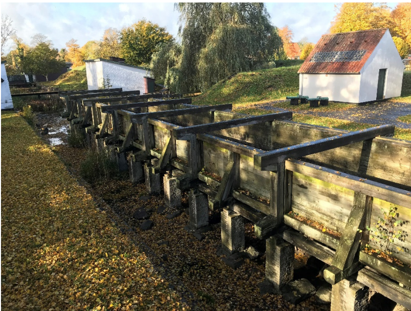
Billedet viser kanalen der med vandkraft drev krudtmøllerne på krudtværket i Frederiksværk. Krudtværket blev gennemgået i forbindelse med udarbejdelsen af rapporten over udstillings- og opbevaringsforhold på Industrimuseet Frederiks Værk. Fotograf: Simon Botfeldt
