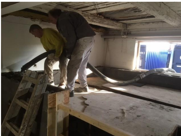
Opbygning af røntgenrum med 28 cm betonvægge og 4mm bly i skydedøren.
